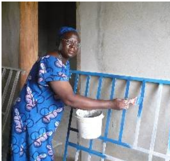
Sr. Mary beim Streichen des Treppengeländers
